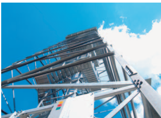
42,5 Meter hoch ist der Eichelspitzturm.
